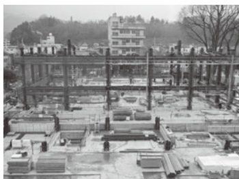
屋上庭園からの工事現場の様子
